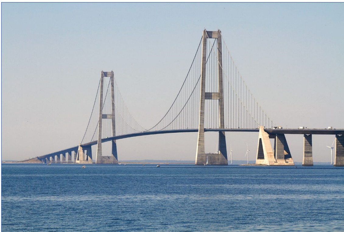
Storebæltsbroens to midterste hængekabler hænger tilnærmelsesvist i en parabelbue
